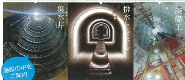
写真：地すべり対策施設
