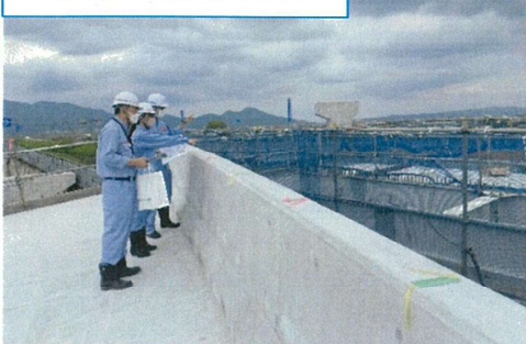
道路の現場視察
