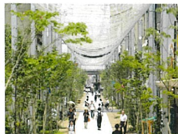
福山本通・船町商店街アーケード'改修
